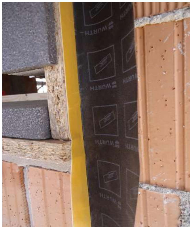
Fissaggio con turboviti e schiuma poliuretana flessibile
